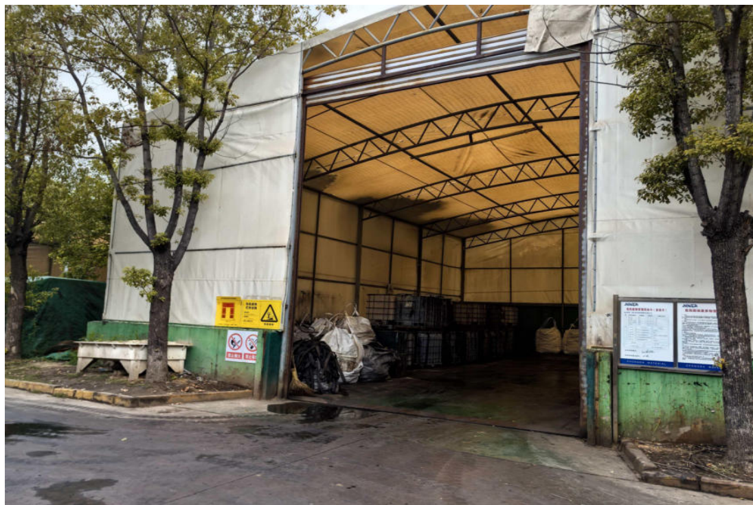
图 4-4 危废暂存场所照片（外部）
