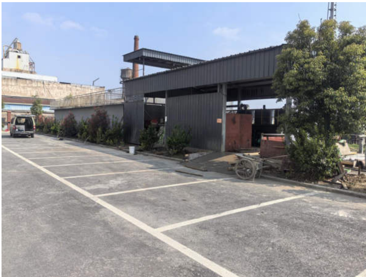
图 4-2 废水治理设施照片
