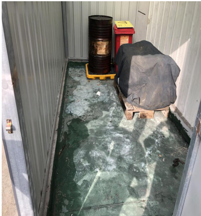
图 4-6 危废暂存场所照片（内部）
