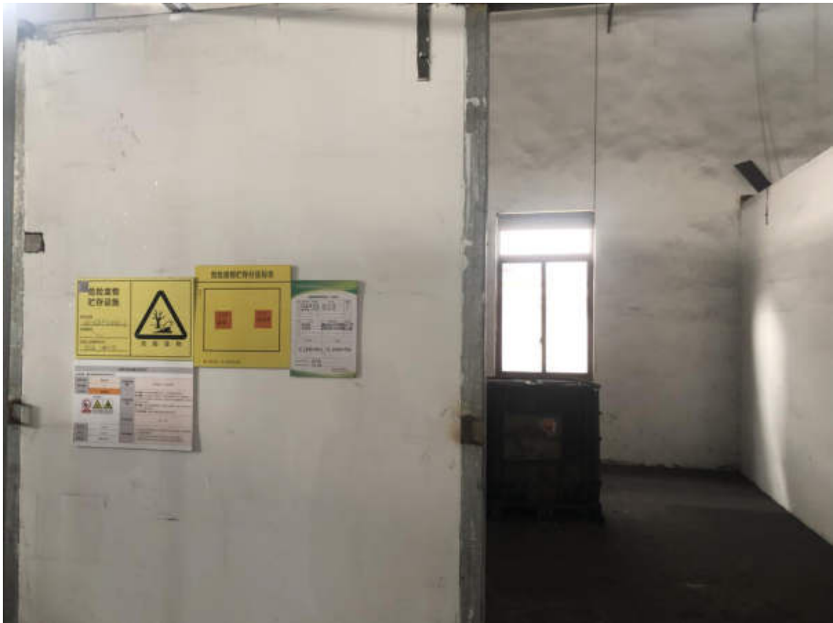
图 4-4 危废暂存场所照片（外部）
