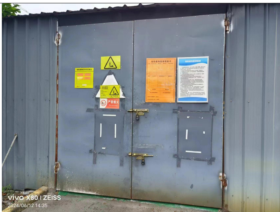
危险废物仓库
