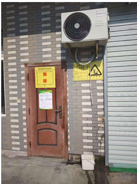
危险废物仓库
