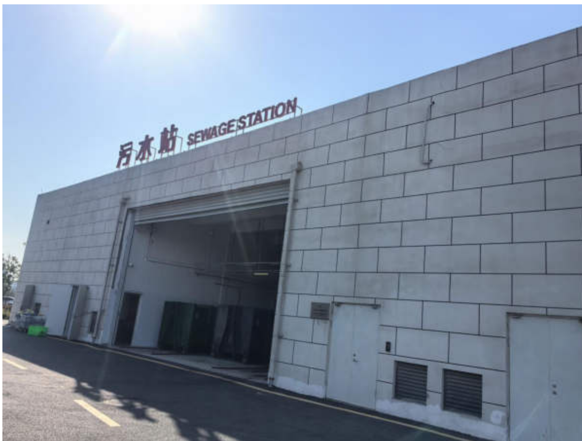
图 4-2 废水治理设施照片
