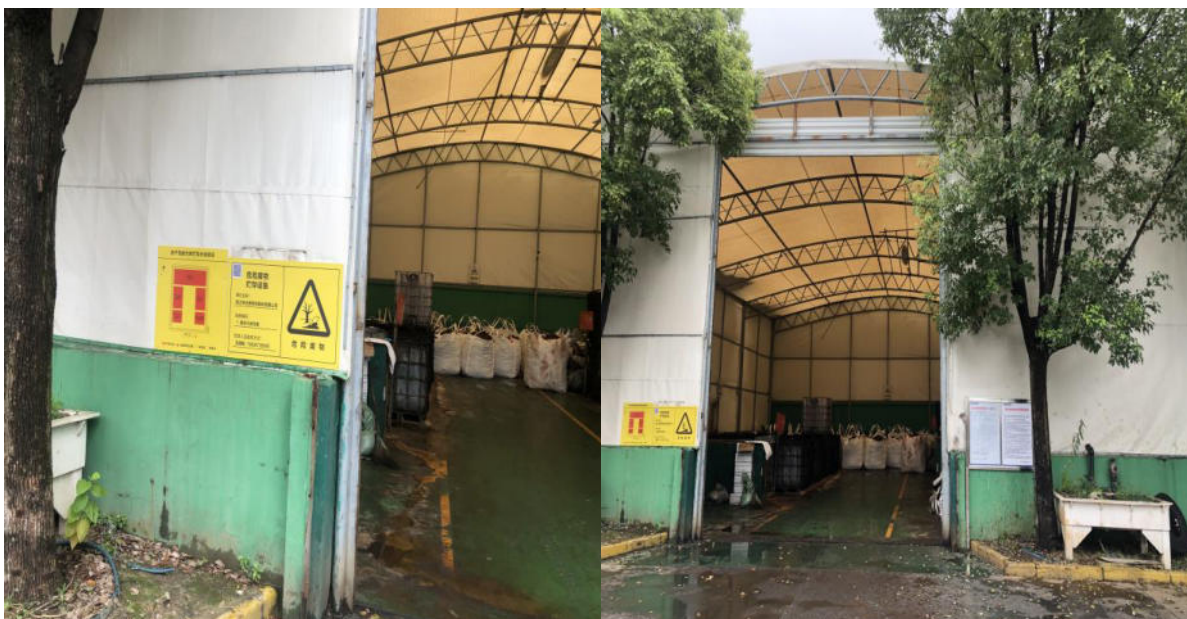
图 4-10 危废暂存场所照片（外部）
