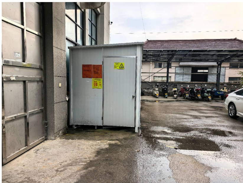
危险废物仓库
