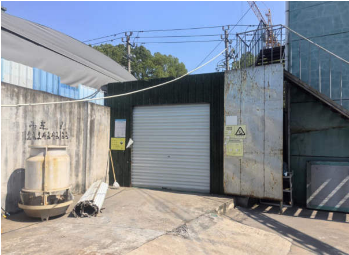
图 4-4 危废暂存场所照片（外部）
